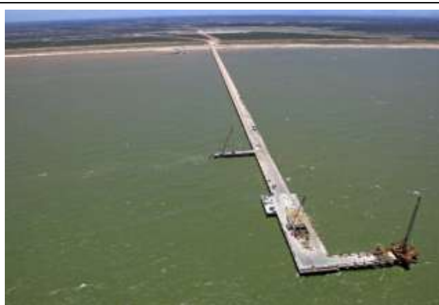
Construção do píer Nov. 2010
