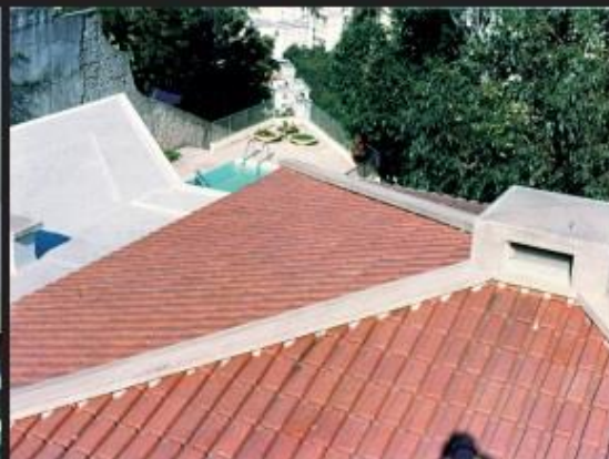
vista da cobertura
