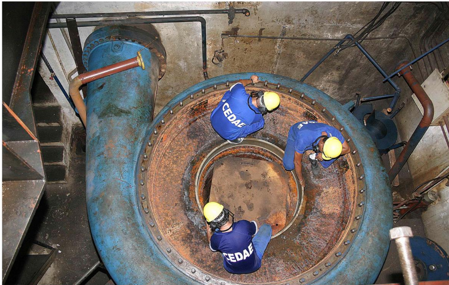
INSPEÇÃO DA BOMBA
