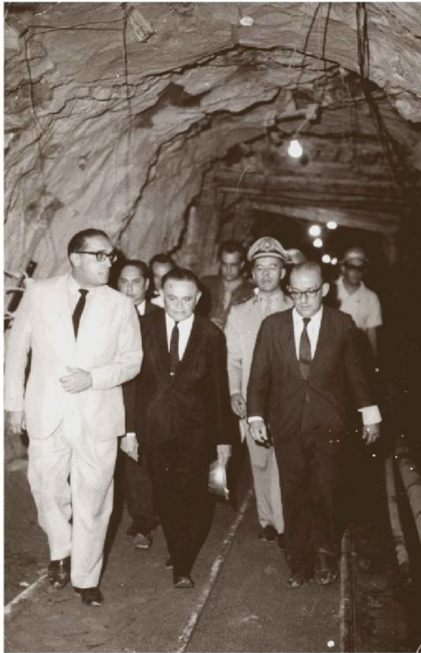
O GOVERNADOR DO ESTADO CARLOS LACERDA, O PRESIDENTE DA REPUBLICA GEN CASTELO BRANCO E O SECRETÁRIO DE OBRAS DR. ENALDO CRAVO PEIXOTO VISITAM AS OBRAS DO TÚNEL DO LAMEIRÃO
