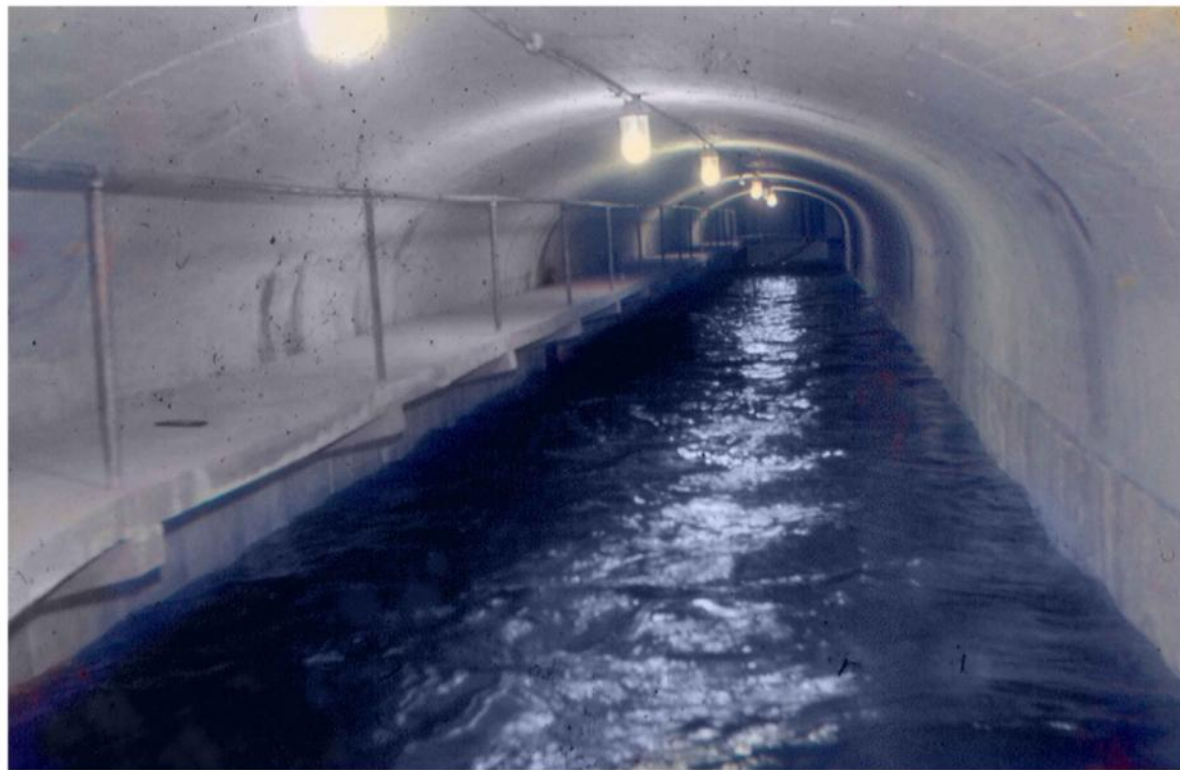
TÚNEL DE CHEGADA DA NOVA ELEVATÓRIA DO LAMEIRÃO - NEL
