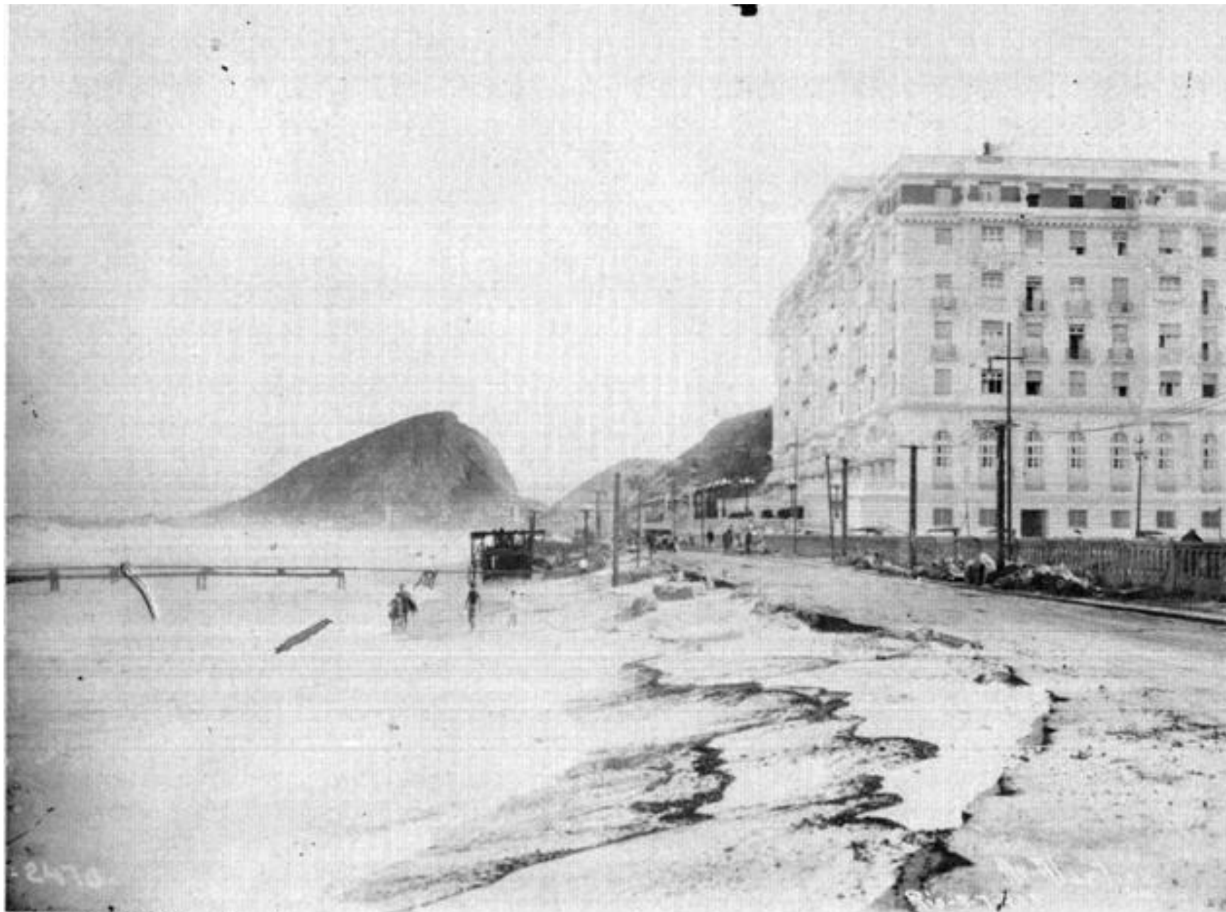
2470 Destruição da Av. Atlântica pela ressaca
