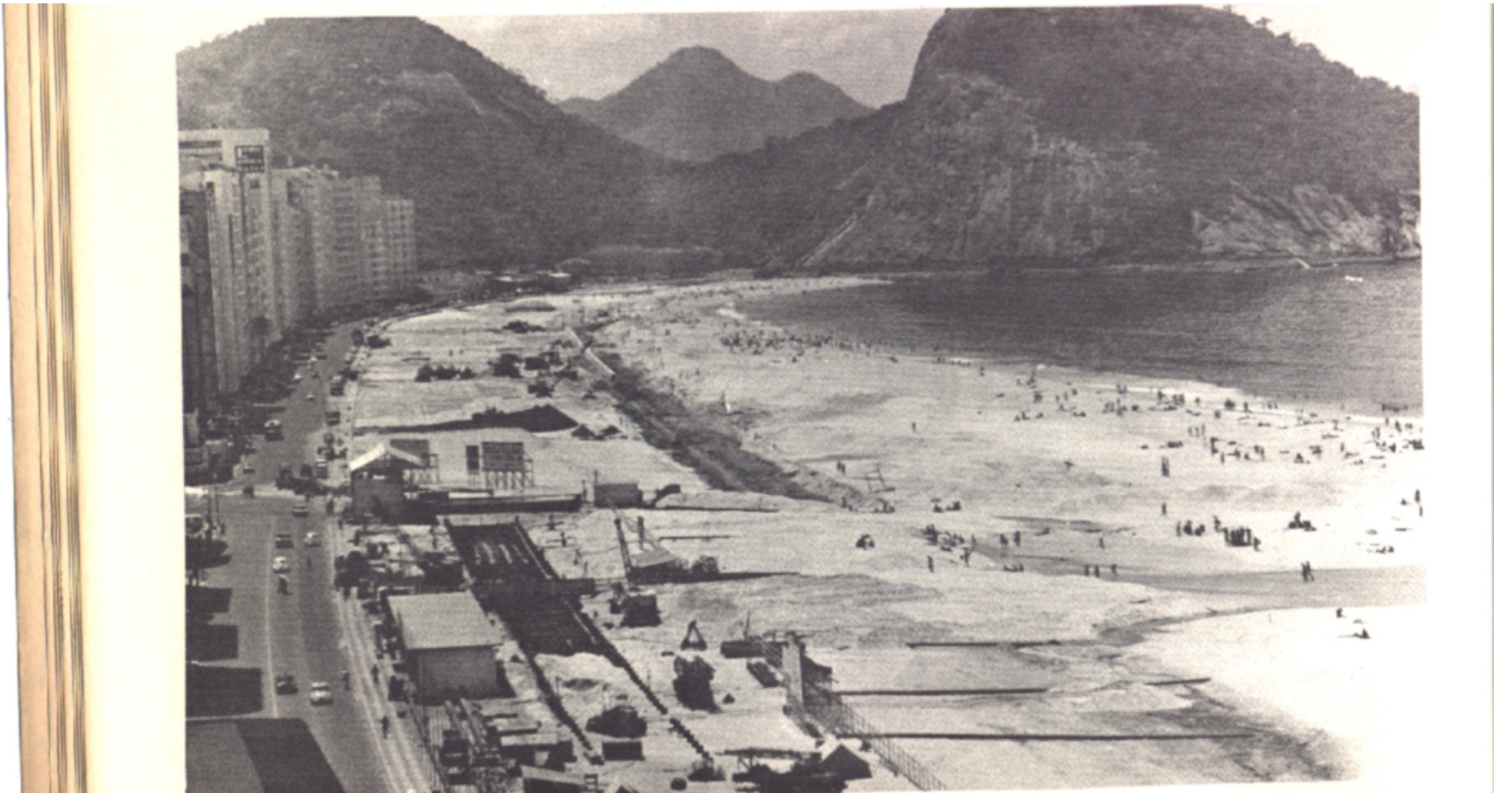
Durante as obras (trecho do leme já alargado) – não havia impedimento ao banho de mar
