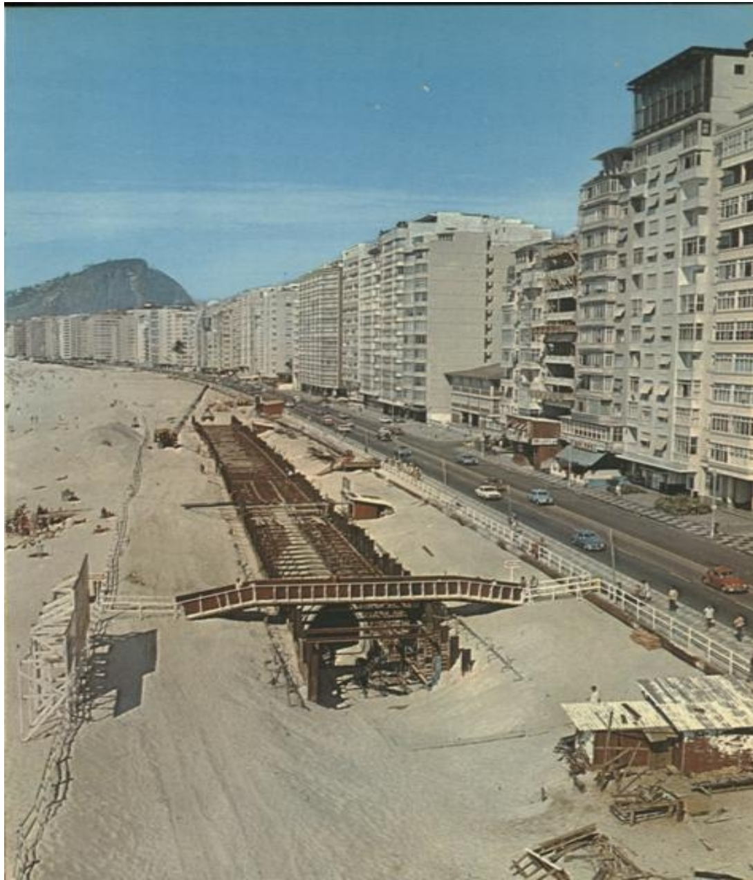
Construção do Interceptor Oceânico, na faixa alargada, impressiona por suas dimensões
