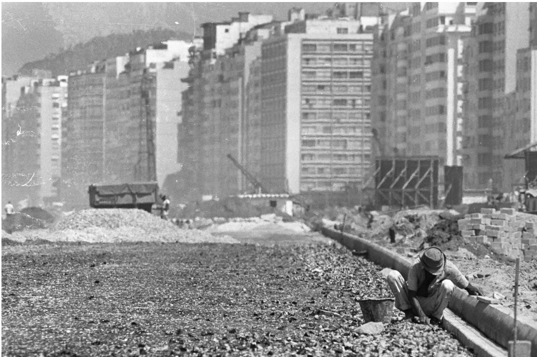
início das obras de pavimentação e calçada junto aos prédios
