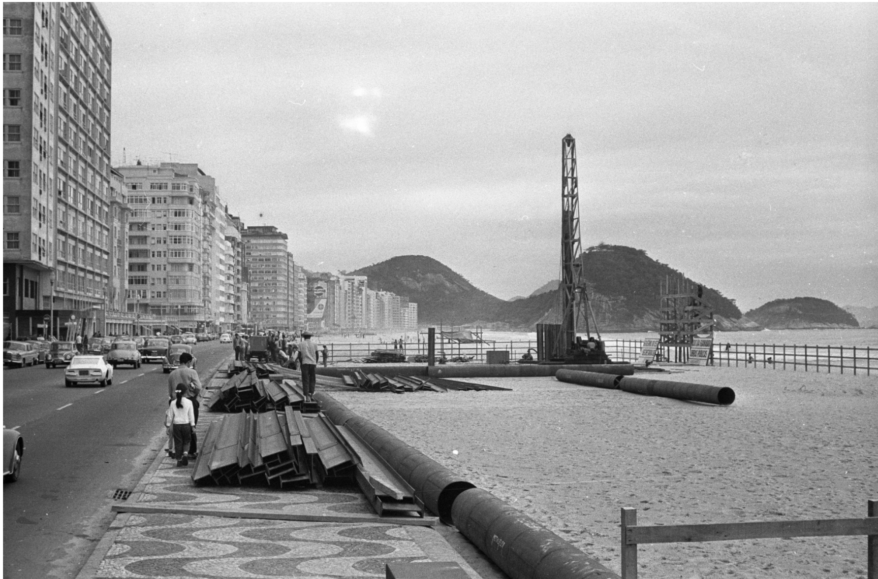
INICIO das obras: instalando as canalizações para transporte da areia vinda da Enseada de Botafogo 1969
