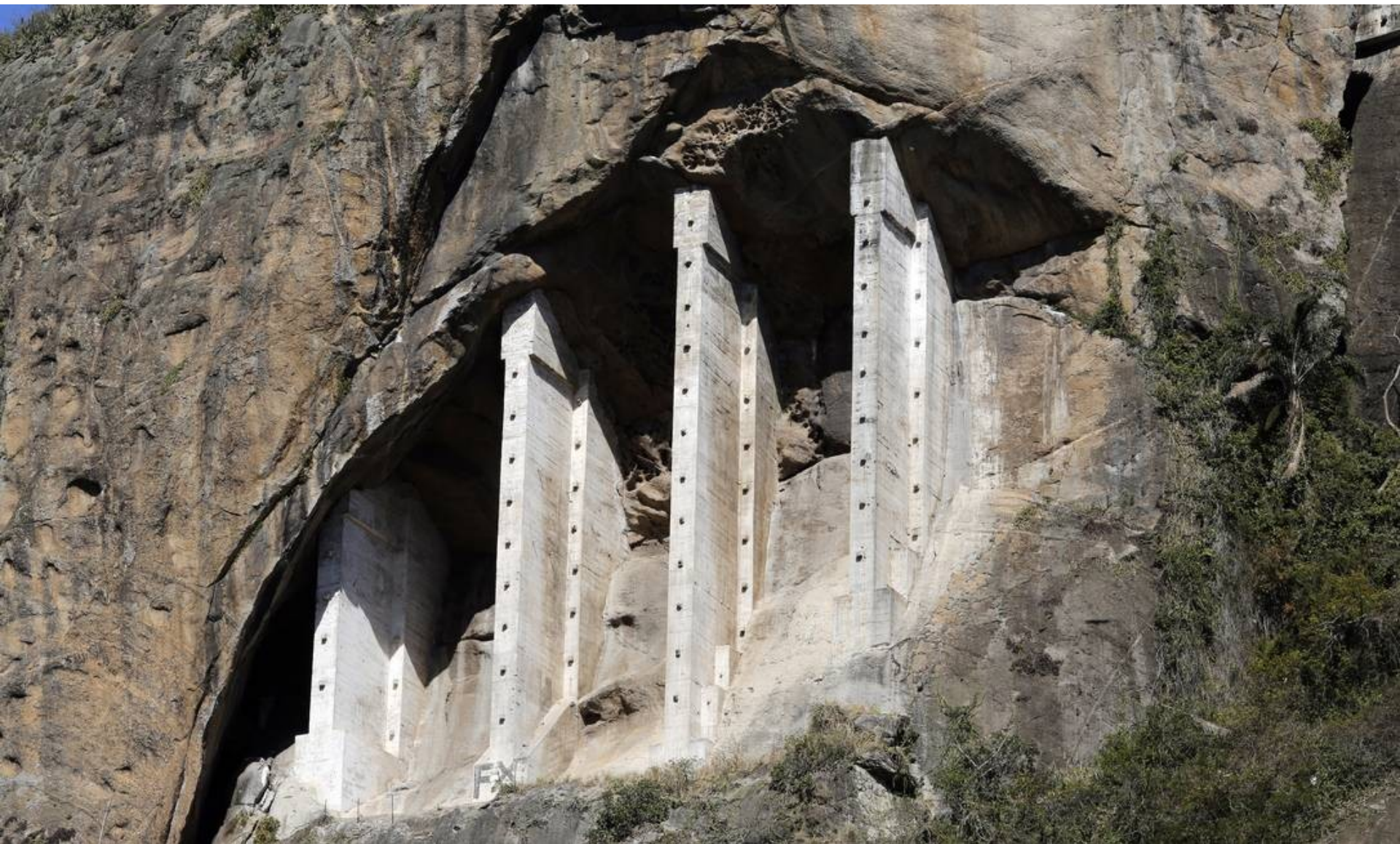
Morro do Cantagalo obras realizadas
