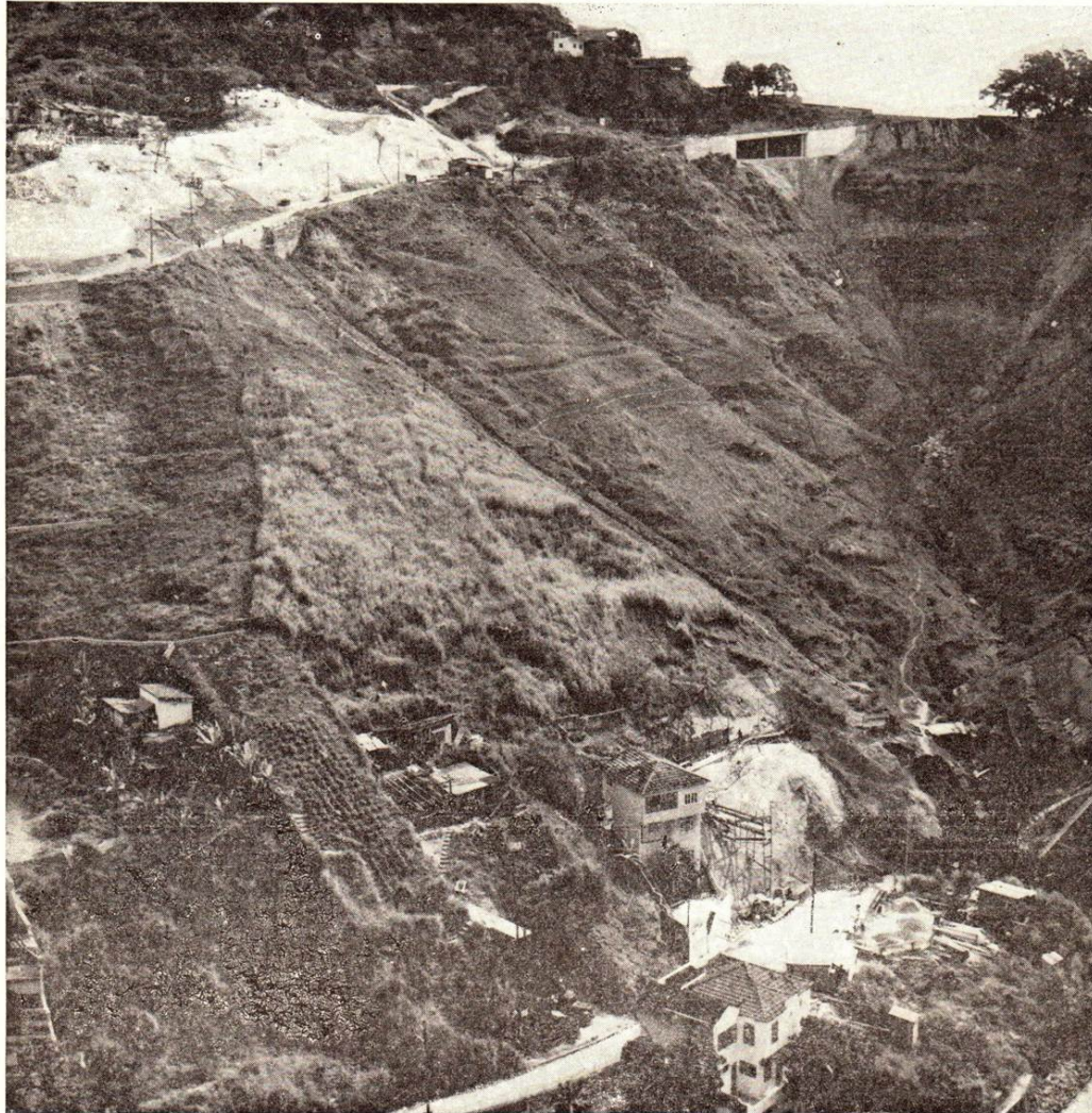
R. Santo Amaro - Grande vale da encosta, vendo-se as marcas da erosão e obras de drenagem superficial e contenção em andamento
