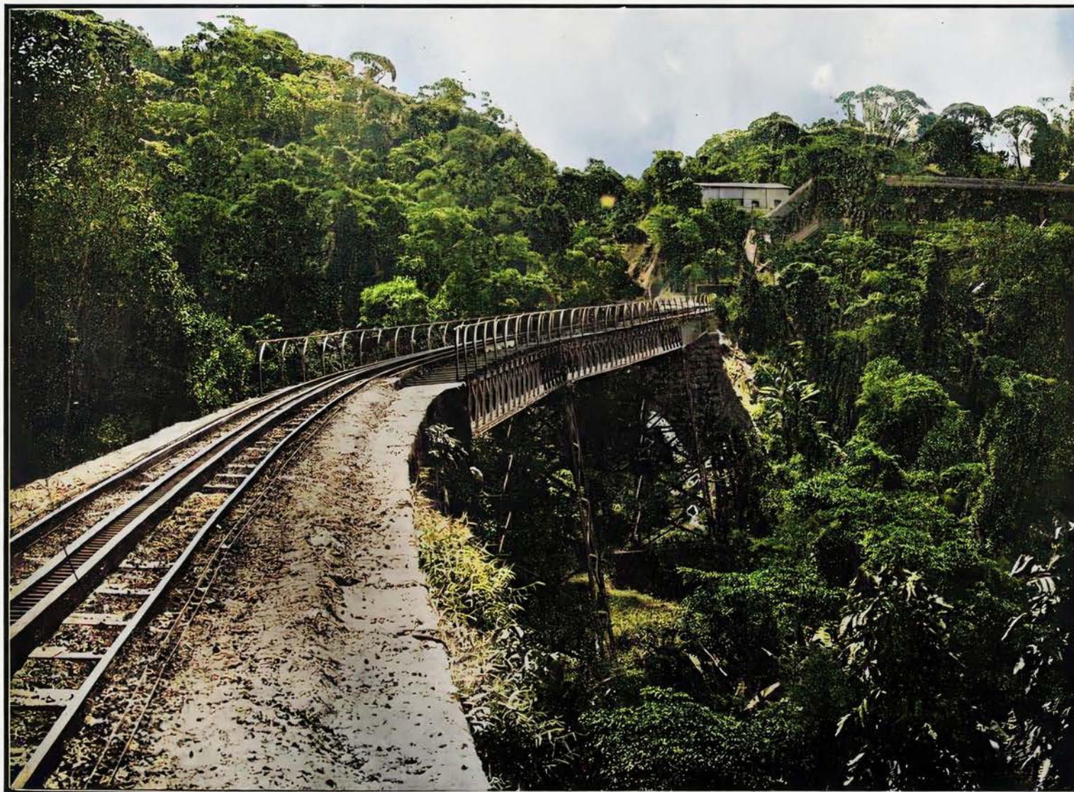
Viaducto do Sylvestre (Estrada de Ferro do Corcovado)
