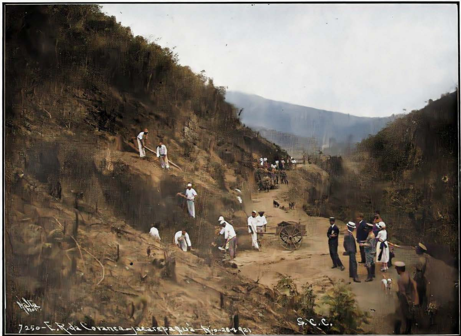
Estrada da Covanca, ligando os suburbios de Meyer e Jacarêpaguá (em construção com aproveitamento de trabalhos de presos correcionaes)
