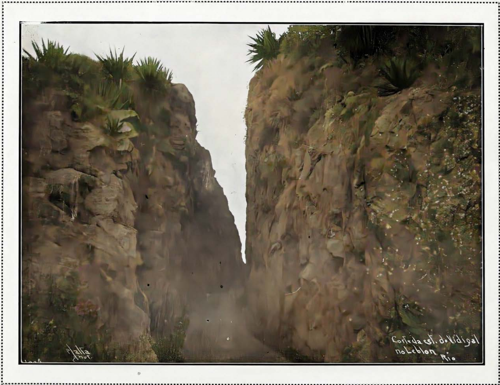
Leblon — (Córte em rocha, dando entrada a Avenida Niemeyer)
