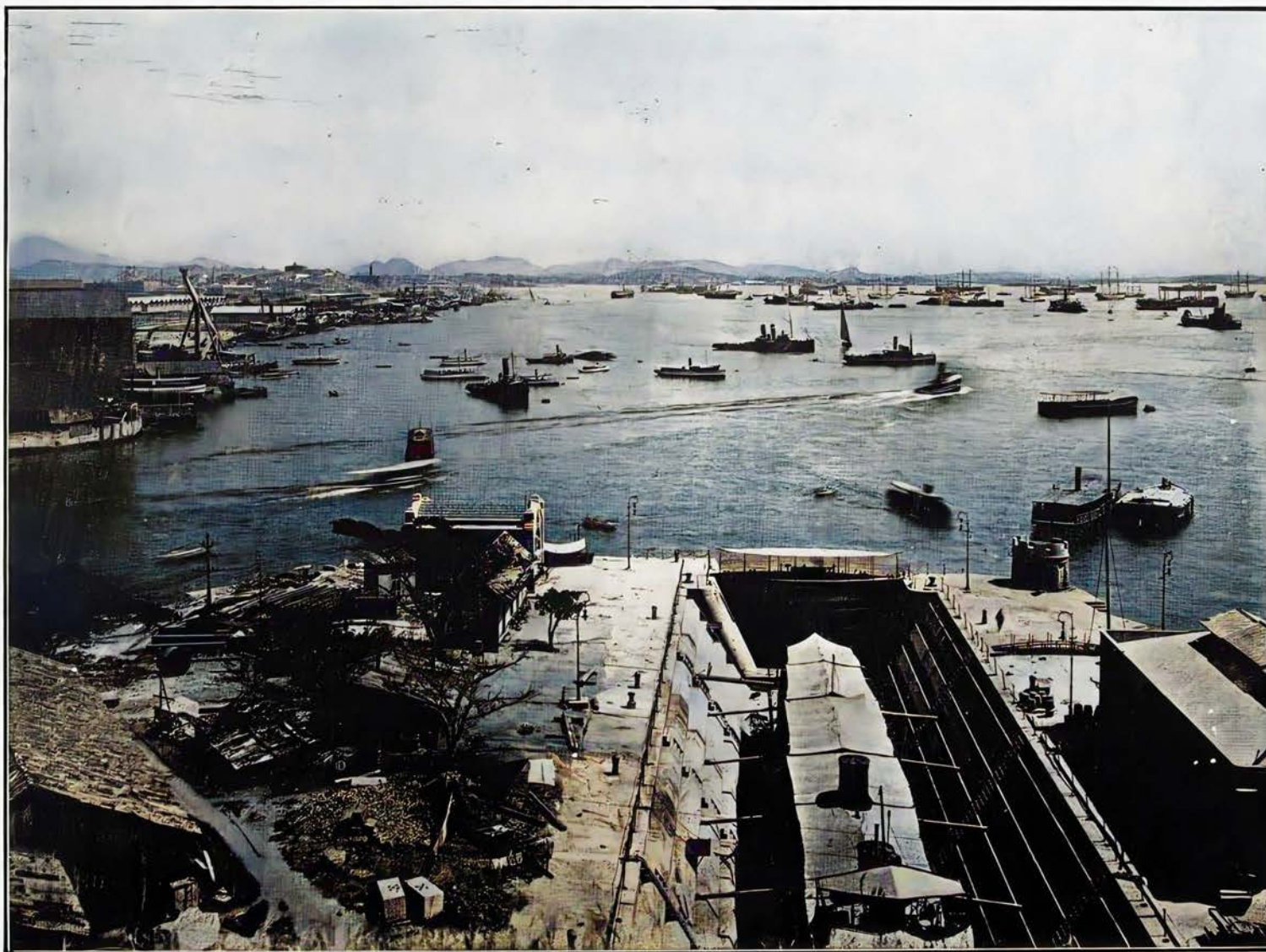
Obras do Cães do Porto
