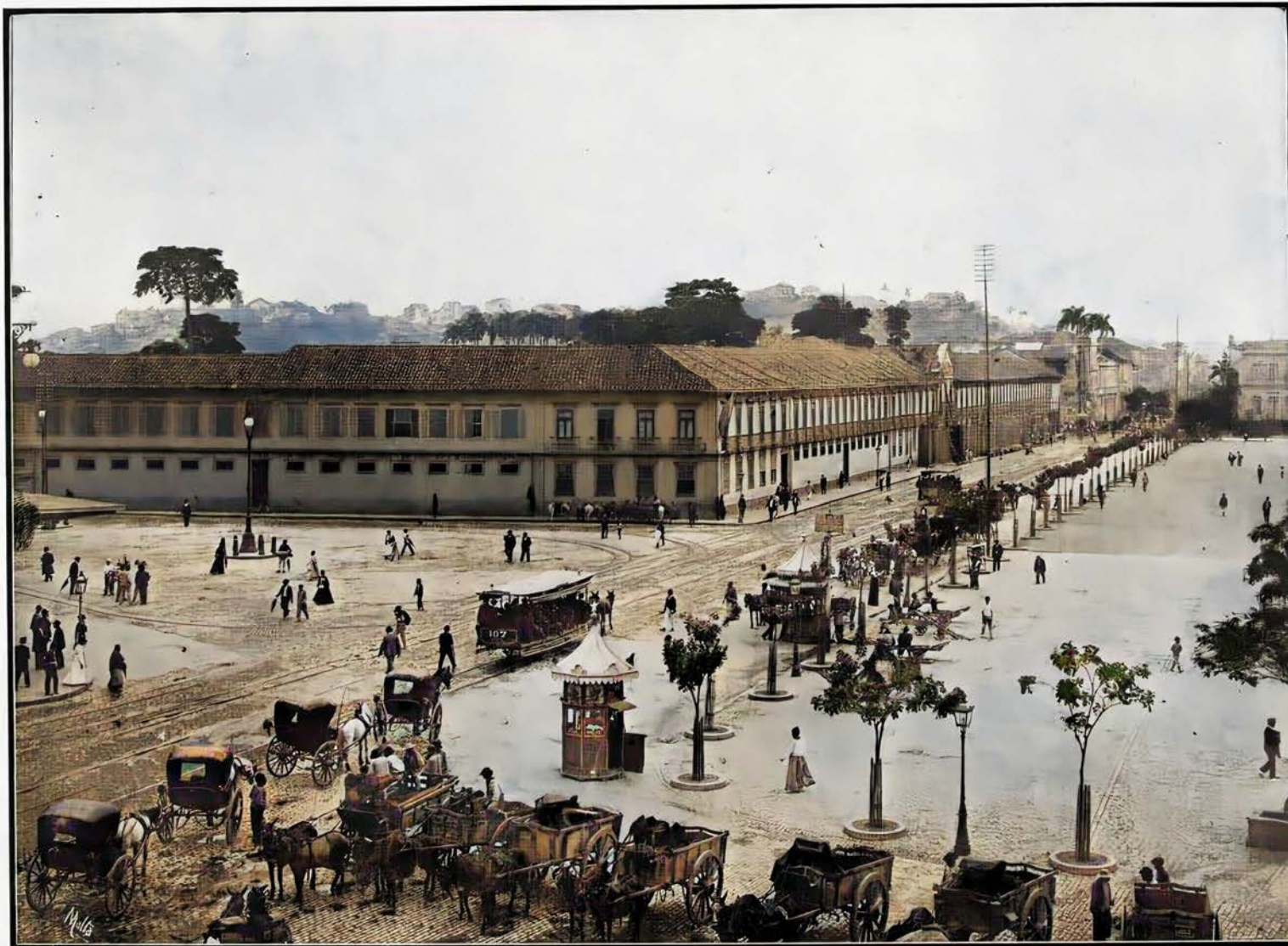
Antigo edifício do Quartel General do Exército Praça da República
